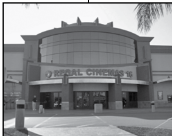
Regal Cinemas, Escondido
